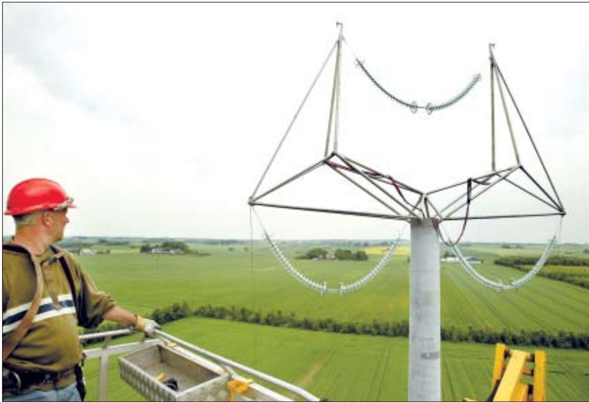
Første designmast på plads ved Bramslev.
