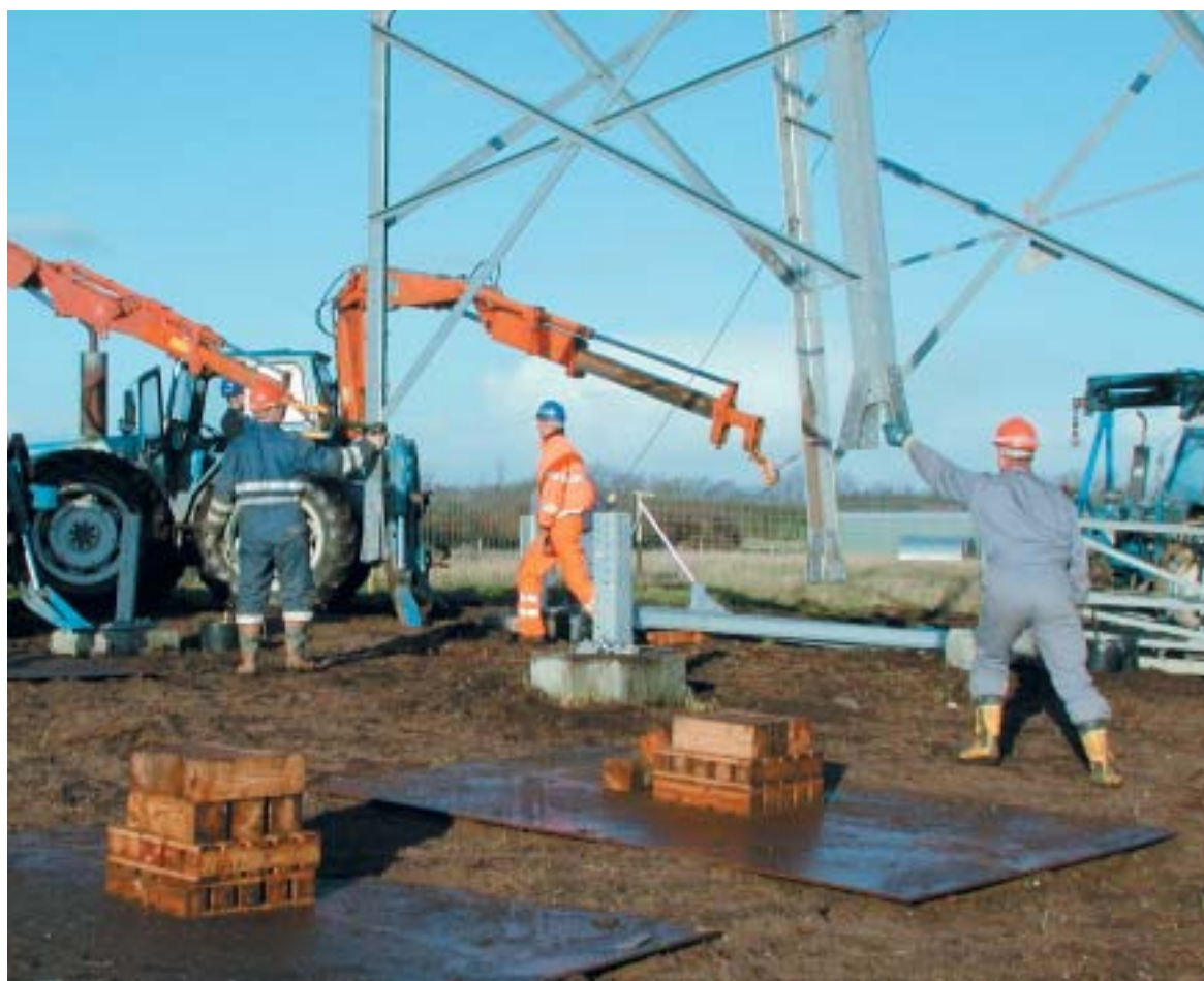
Montage af en 400/150 kV mast på fundamentet på strækningen Smorup-Ferslev.
