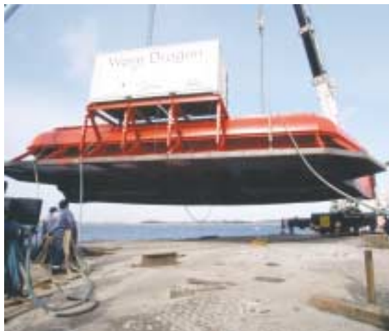
Wave Dragon bølgekraftanlæg sættes i søen ved Nissum Bredding.
