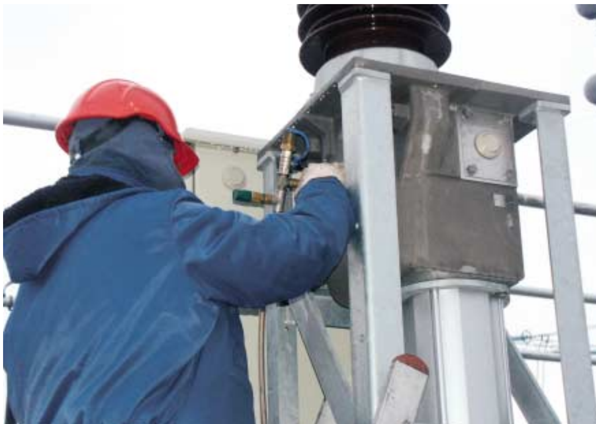
Påfyldning af SF 6 -gas på 400 kV-afbryder, station Trige.
