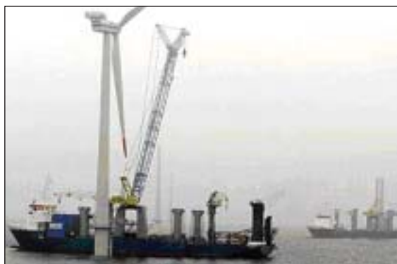
Figur 4 A2SEA-skib under montagearbejde på Horns Rev.
