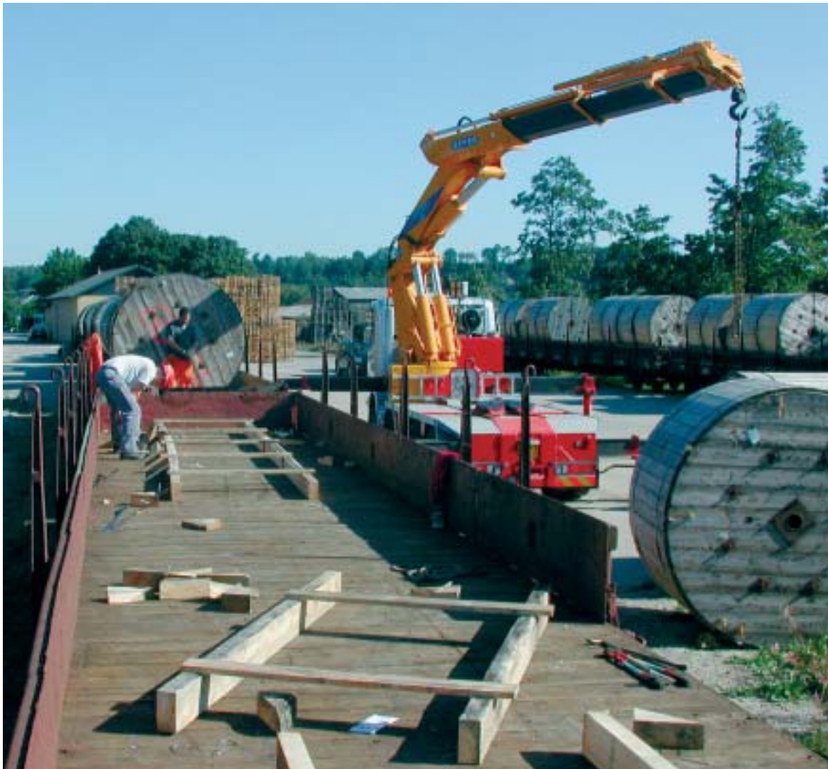
På Hobro station aflæsses faseledere til 400/150 kV delstrækningen fra Hornbæk til Katbjerg, hvor byggeriet af Vendsysselværket-Trige er igangsat.
