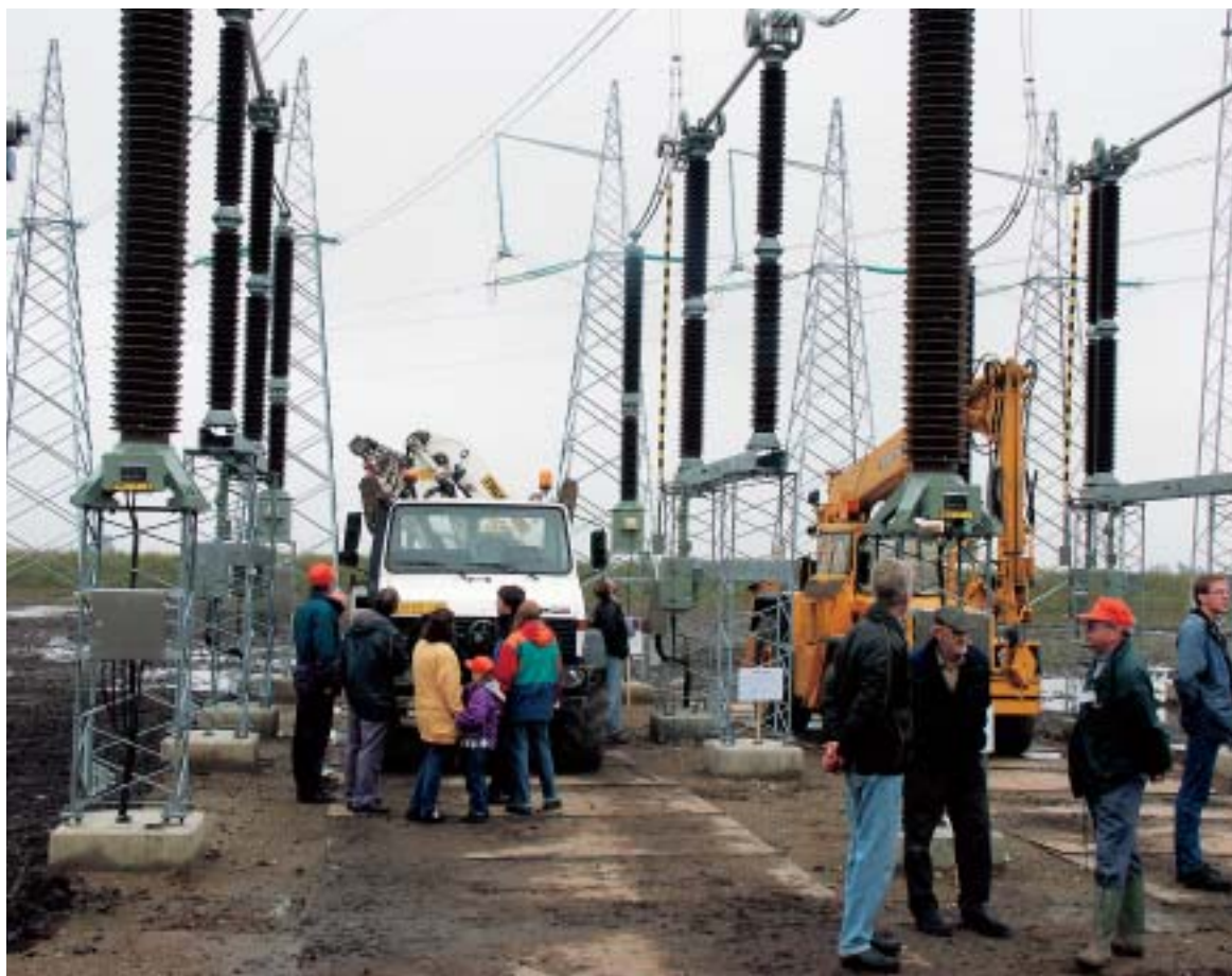
Interesserede mødte frem i stort tal, da Eltra og Vestjyske Net holdt åbent hus på den nye, fælles transformerstation Endrup nord for Bramming lørdag den 29. september 2001.
