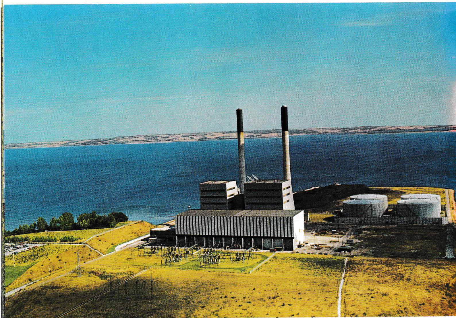
Studstrupværket efter idriftsættelsen af B2 (263 MW). På værket er nu installeret 2 enheder med en samlet effekt på 415 MW.
