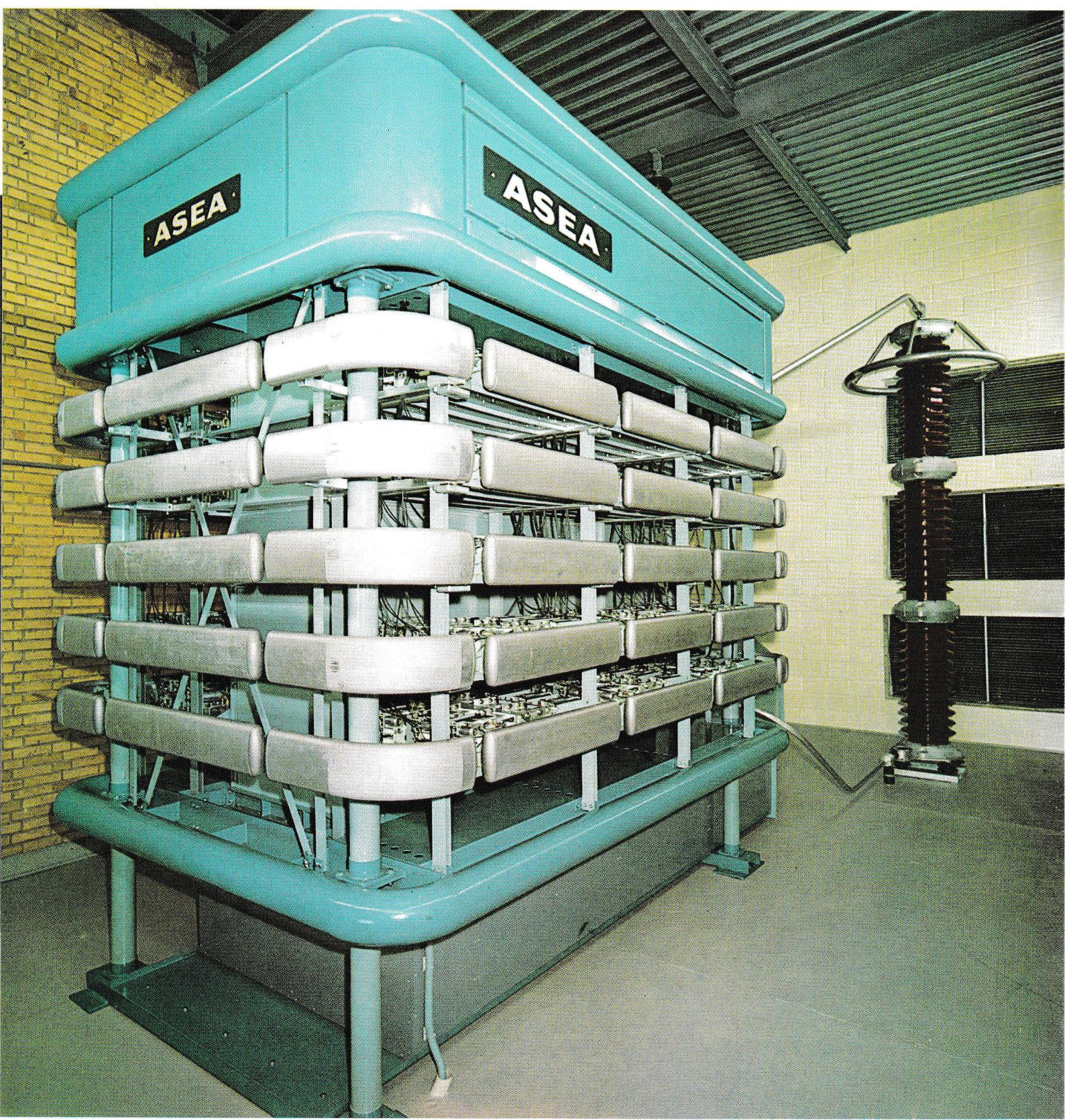
I samarbejde med Norges Vassdrags- og Elektrisitetsvesen og Asea har Elsam installeret en tyristorventil i Vester Hassing stationen. Ventilen står i en separat bygning og er elektrisk forbundet således at den ved normal drift erstatter én af jonventilerne. Den skal give værdifulde driftserfaringer til brug i Norgesforbindelsen.
