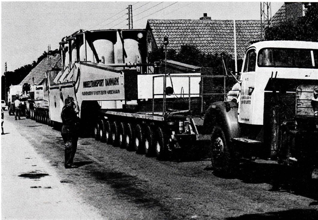
Transporten af 220/150 kV transformatoren fra Tange til Kassø udførtes som ren landevejstransport.
