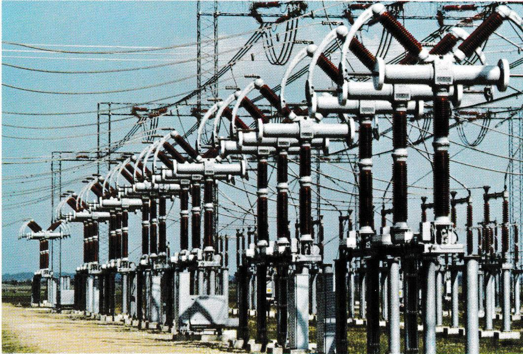
AEG trykluftafbryder installeret i 150 kV delen af 220/150 kV station Kassø.
