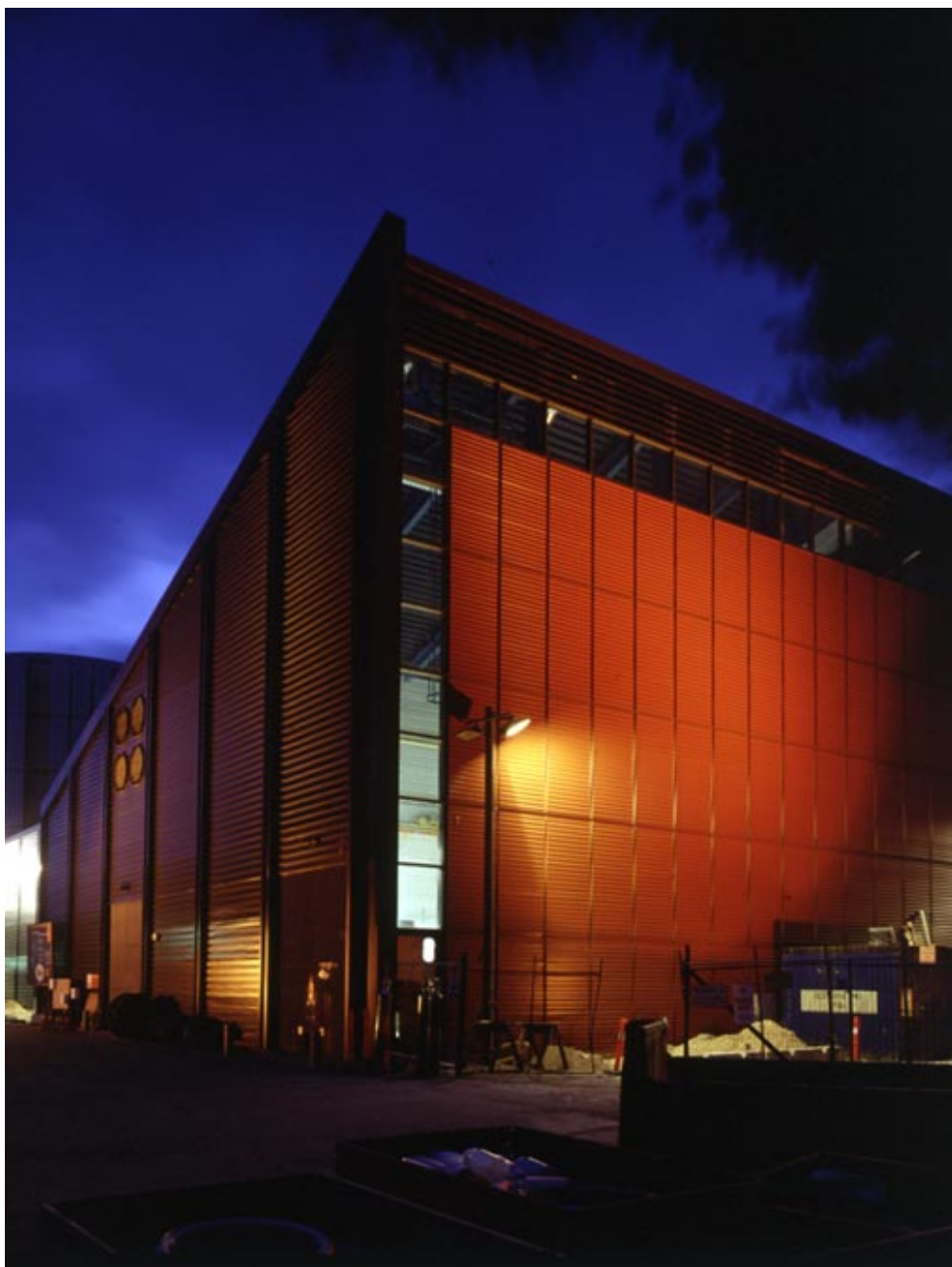
DTU- Sjællandske Kraftværkers naturgasfyrede decentrale kraftvarmeværk på Danmarks Tekniske Universitet gik i drift i december 1998. Foto: Mogens Carrebye
