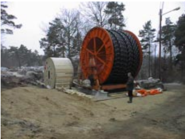
Läggning av markkabel för SwePol Link på Sternö, Karlshamn. Foto: Ragnvald Åberg
