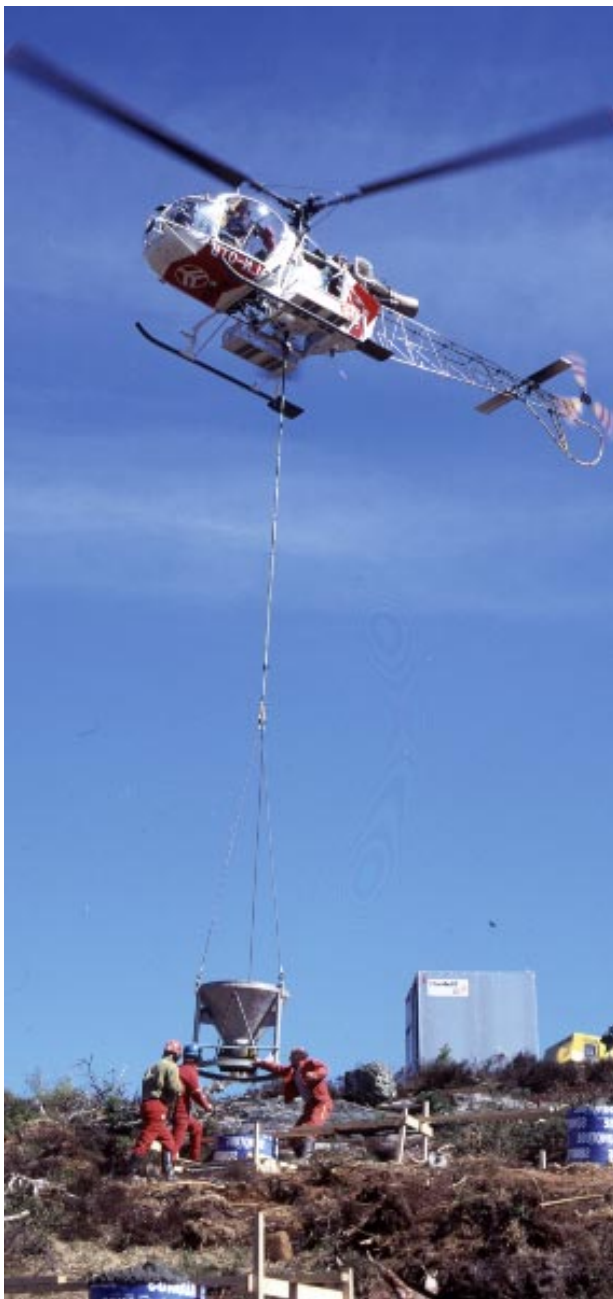
Fra fundamenteringsarbeidet på den nye linja Kristiansand-Evje, fundamentforskalingene fylles av betong fra helikopter. Foto: Tor Oddvar Hansen
