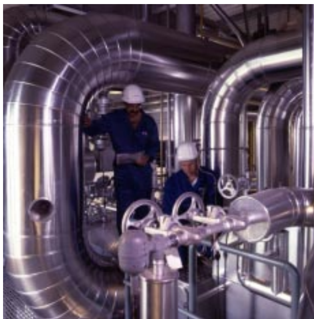
Kolkraftverket i Nokia, som ägs av PVO-Group byggdes om till ett gaskombikraftverk. Foto: Markku Korpi-Hallila
