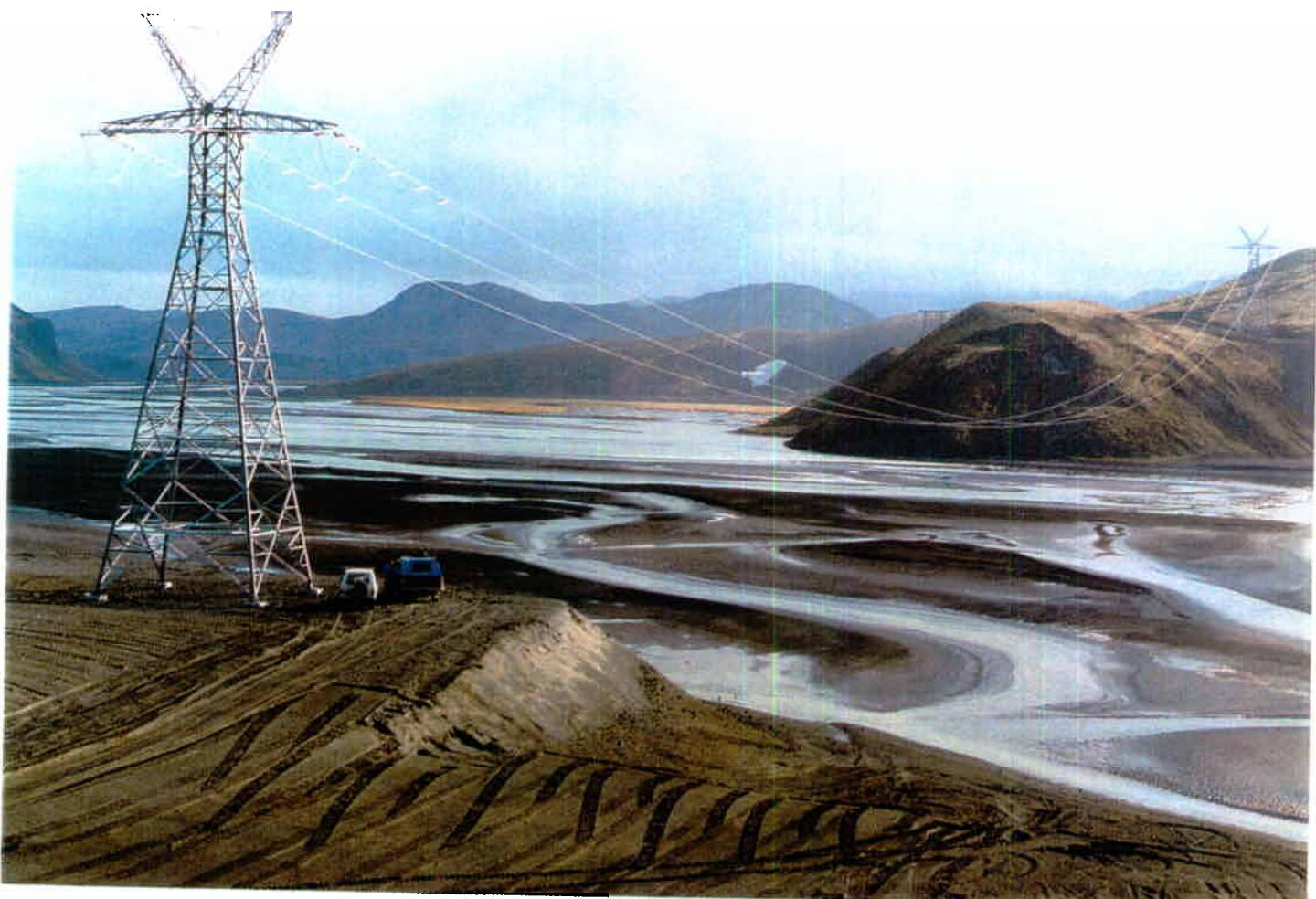
På bilden är 132 kV ringledningen spänd över en 564 m bred jökelälv
