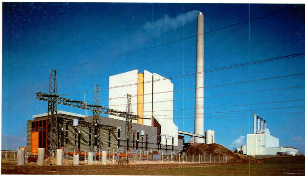
Asnæsværket ved Kalundborg i det nord-vestlige Sjælland vil med den nye kraftværksenhed, blok 5, være landets største kraftværk på 1.410 MW netto.
