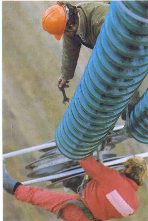
400 kV linien Asnæs-Hovegård. Montering af de enkelte ledningstøve i hængeklemmer i enden af isolatorkæderne, sker i en arbejdshøjde på ca. 40 m.
