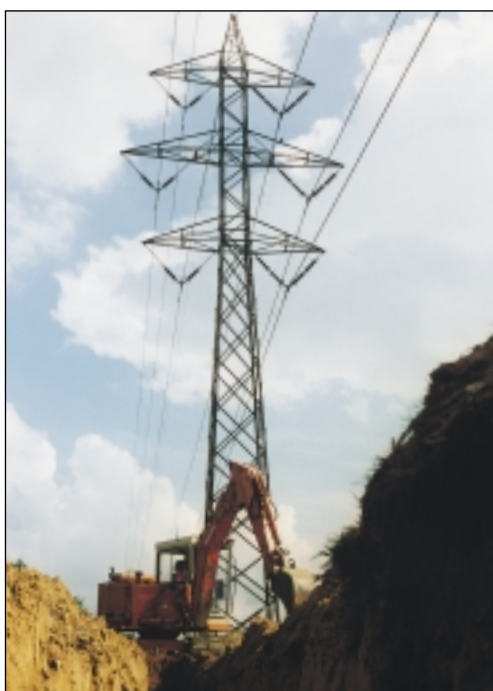
Luftledning erstattes med kabler.
