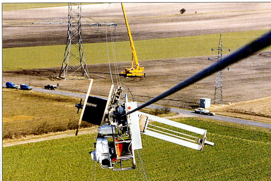
Telesystemet udbygges ved hjælp af lyslederkabler, som snoes omkring højspændingsnettets jordledere.
