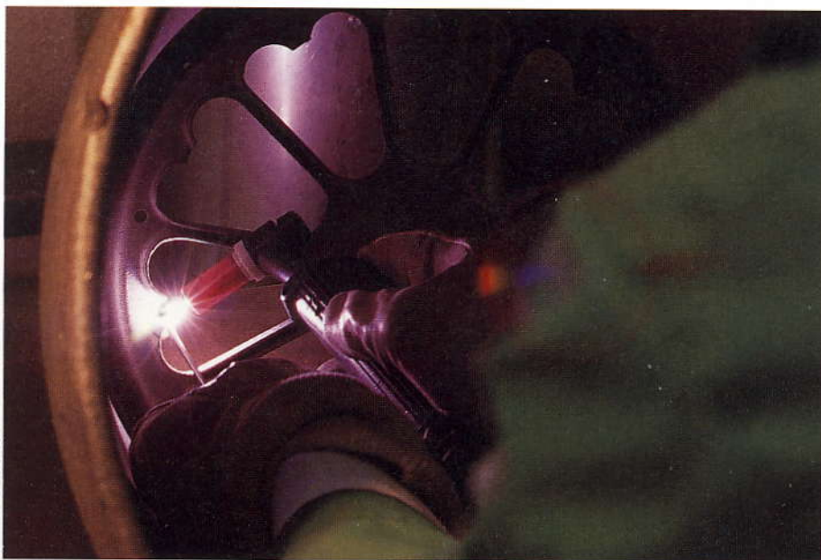
Elektrode i kviksolvensretter repareres (Jævnstrømsstationen Vester Hassing).
